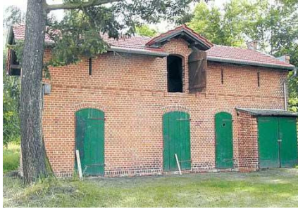
Die "alte" Scheune
